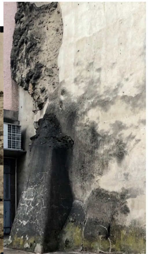
Dernier vestige des remparts du « Château », rue Lansecot
